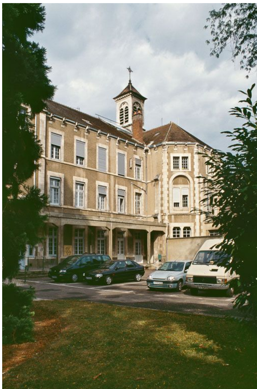
Bâtiment central, façade postérieure avec galerie en 2001.
