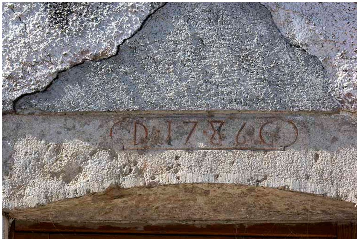
Maison de 1786, façade antérieure : linteau daté.
