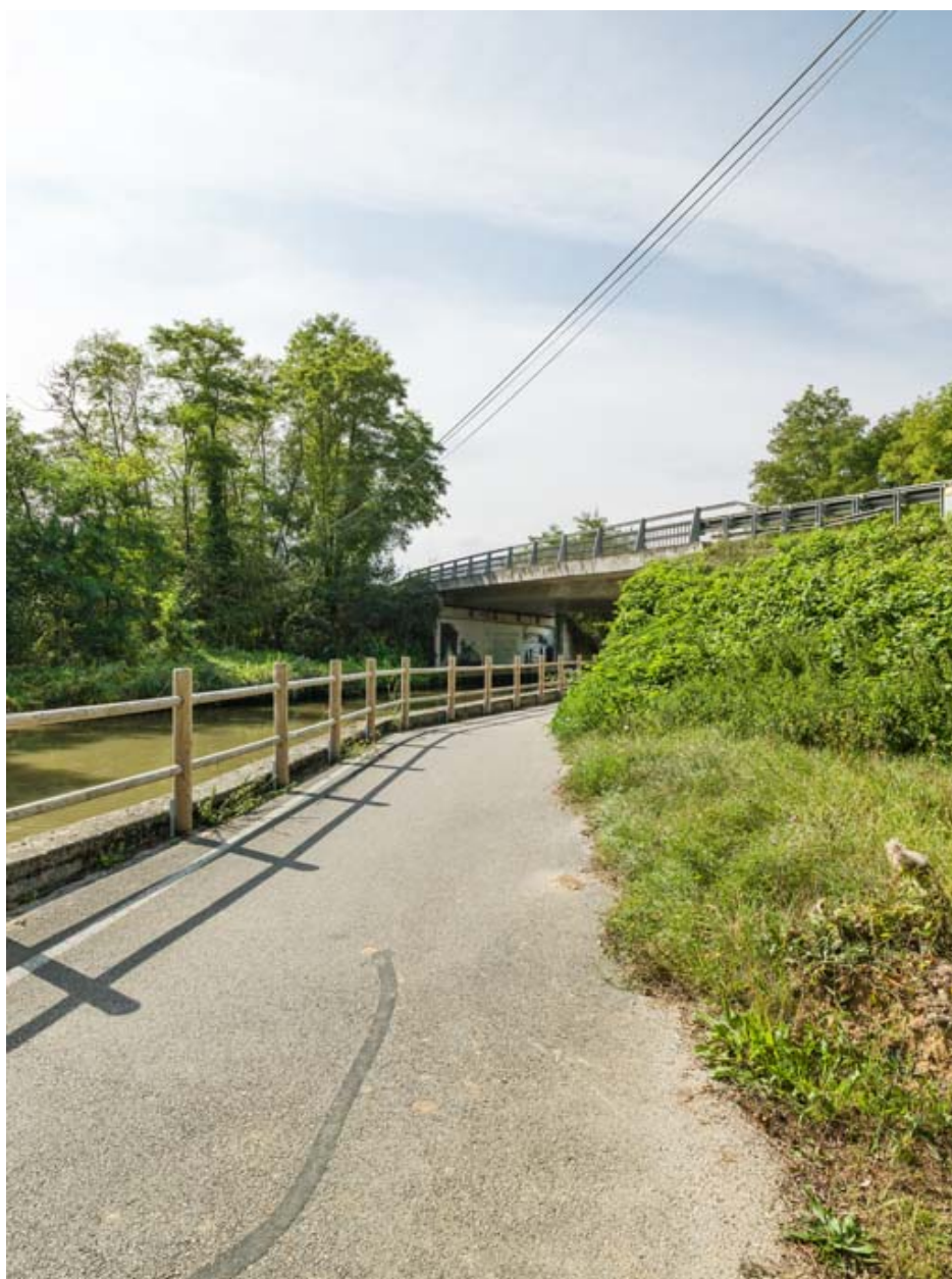
Vue d'ensemble du pont et du canal.
