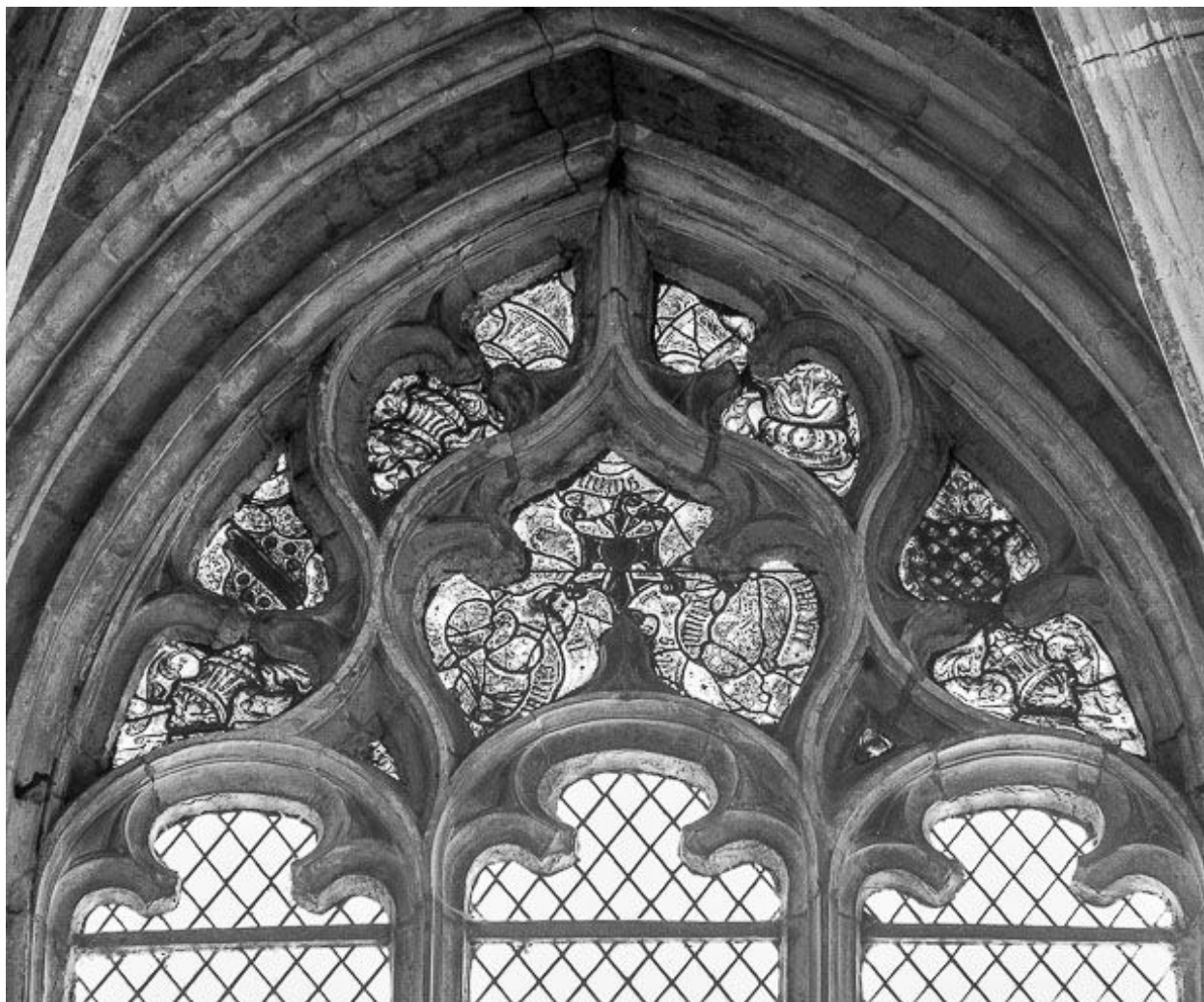
Tympan d'une des baies latérale.
