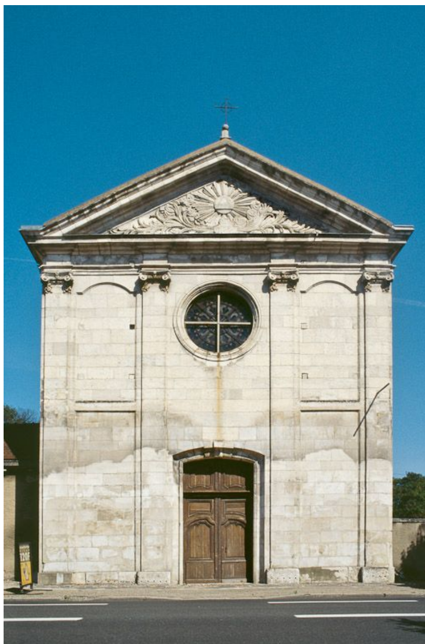
Façade de la chapelle.
