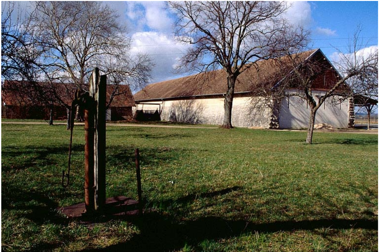
Magasin industriel vu de trois quarts arrière.
