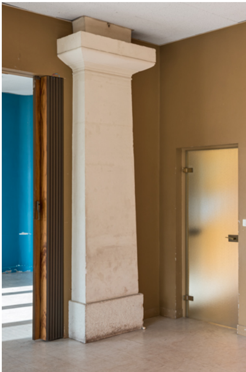
Ancienne halle au blé : pilier.
