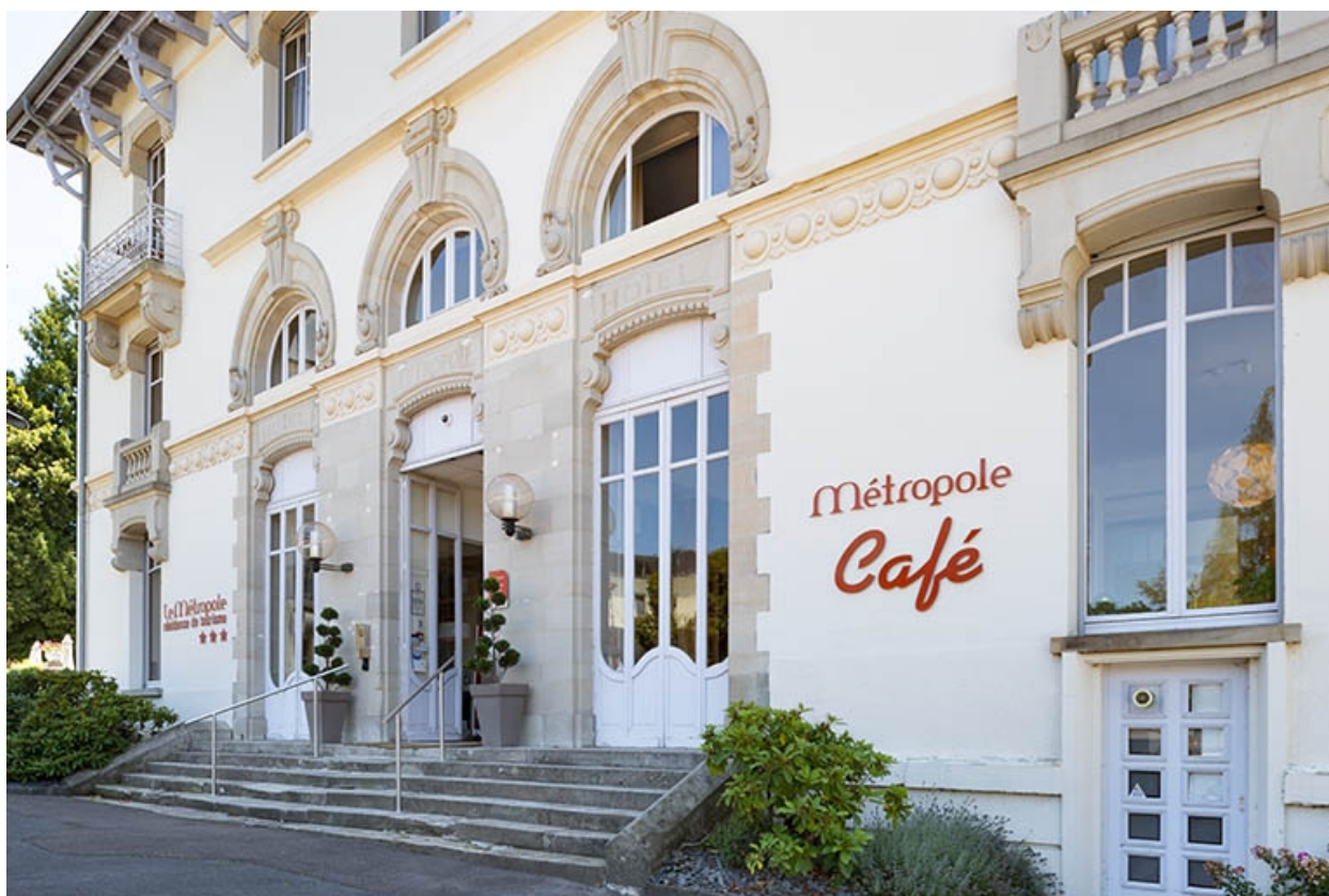
Façade nord, vue de trois quarts, détail.
