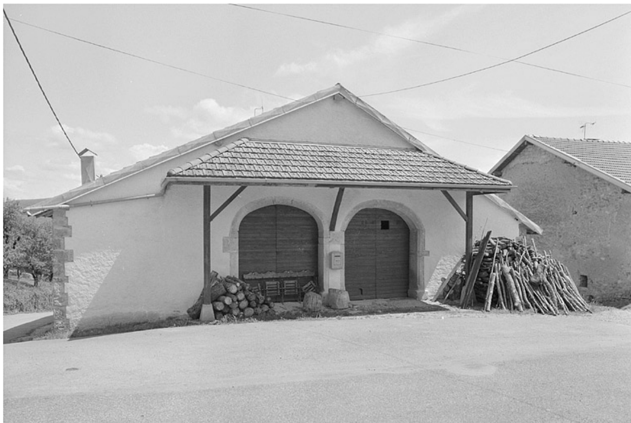
Façade postérieure avec granges hautes.
