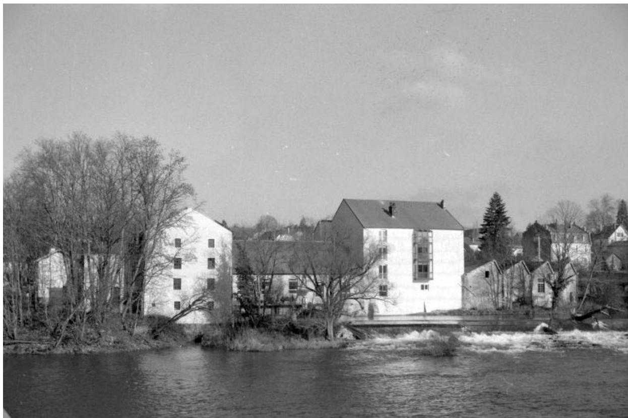
Vue d'ensemble depuis le sud, en 1990.
