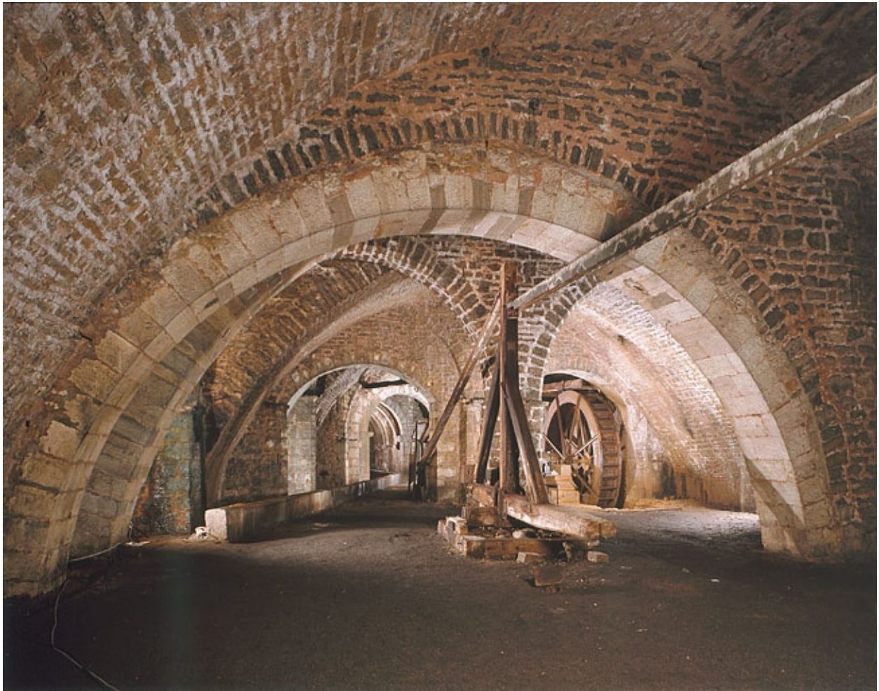
Saline de Salins-les-Bains : le système d'exhaure du puits d'Amont.
