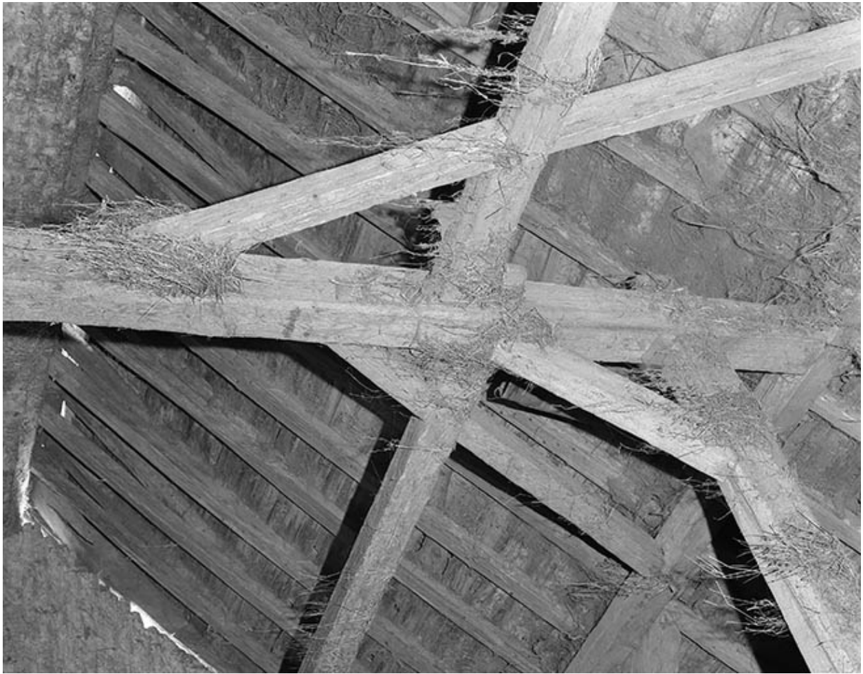
Poteau de charpente latéral d'une ferme.
