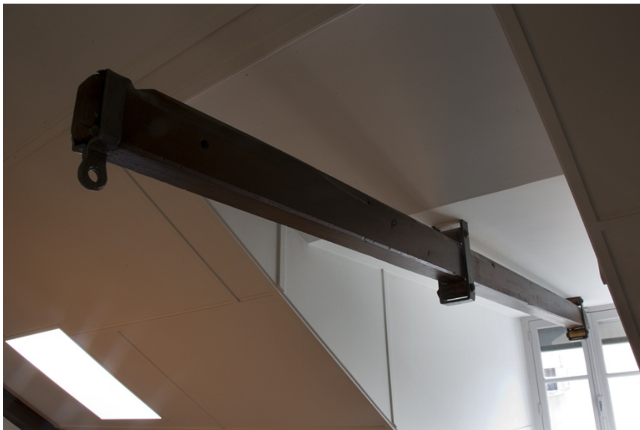
Aile droite, intérieur : détail d'un monte-charge.
