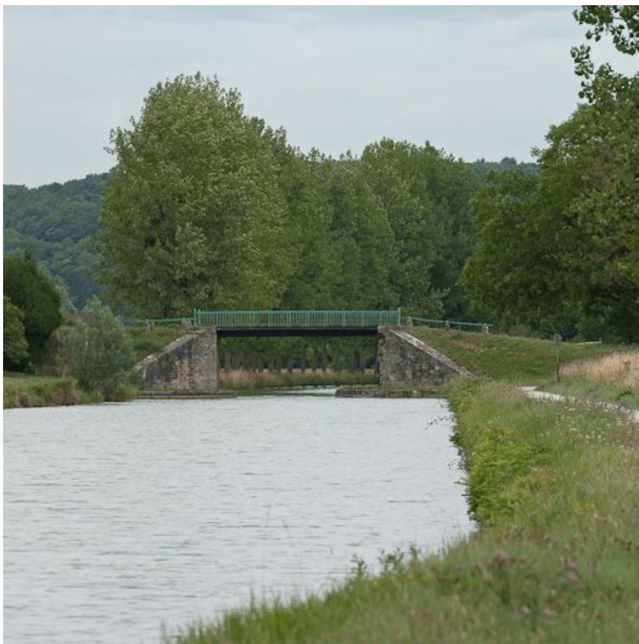
Vue du pont.
