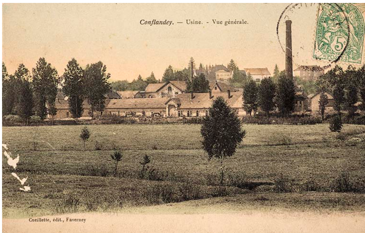
Vue générale de l'usine, Conflandey.
