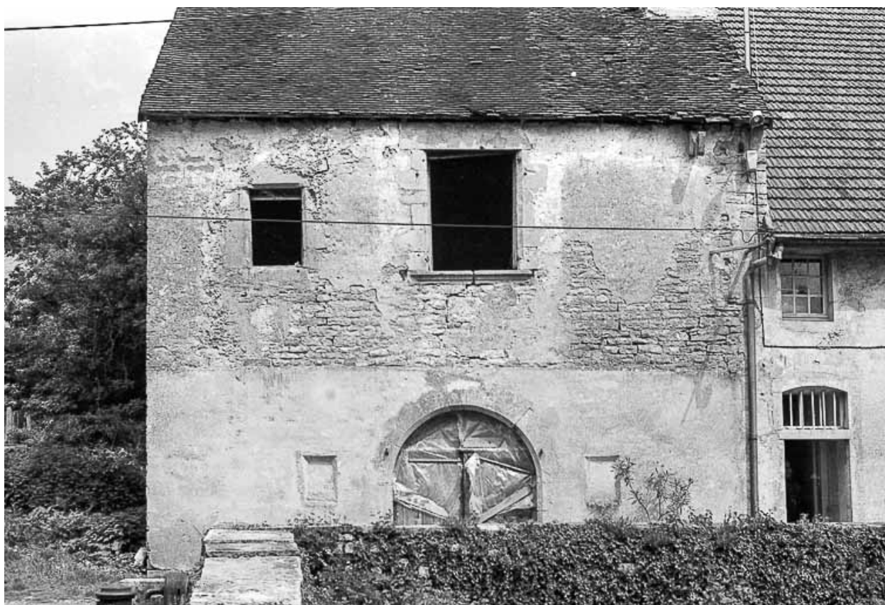
Maison attenante au presbytère : façade postérieure.
