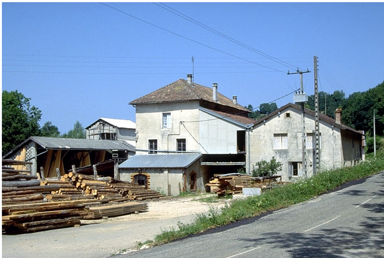
Scierie, ancienne tournerie et ancienne huilerie.
