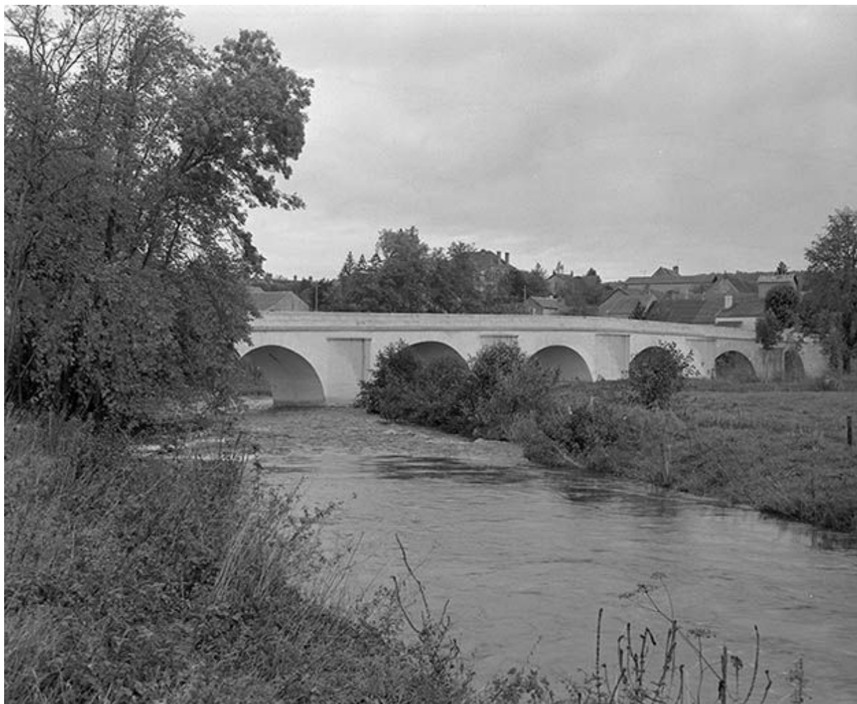
Vue prise de l'amont.
