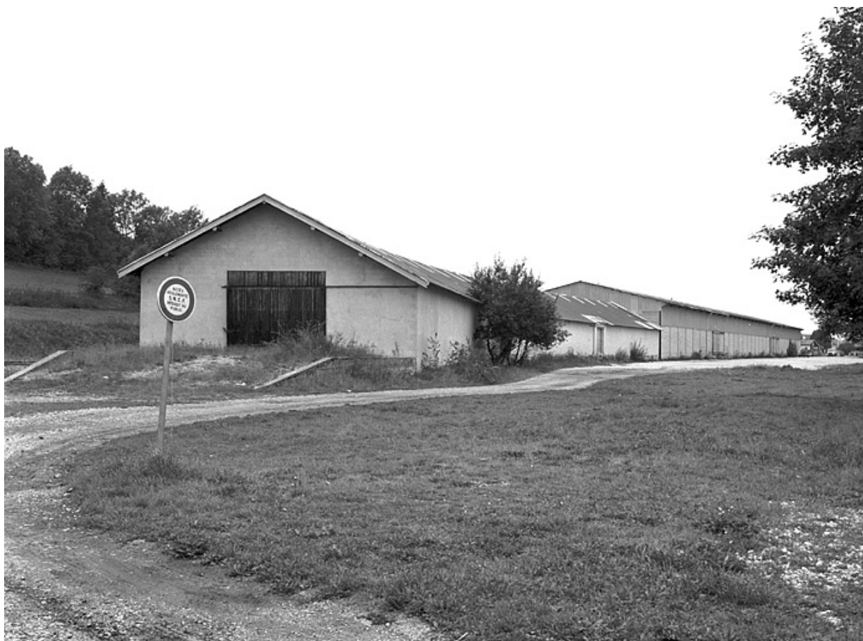
Entrepôts, depuis le sud-est.
