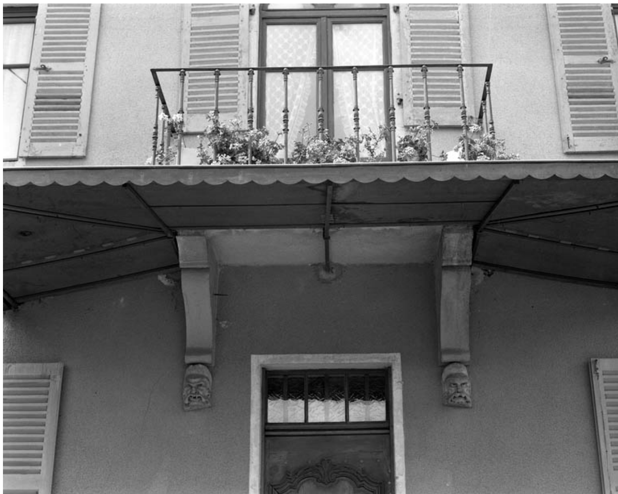
Détail du balcon.
