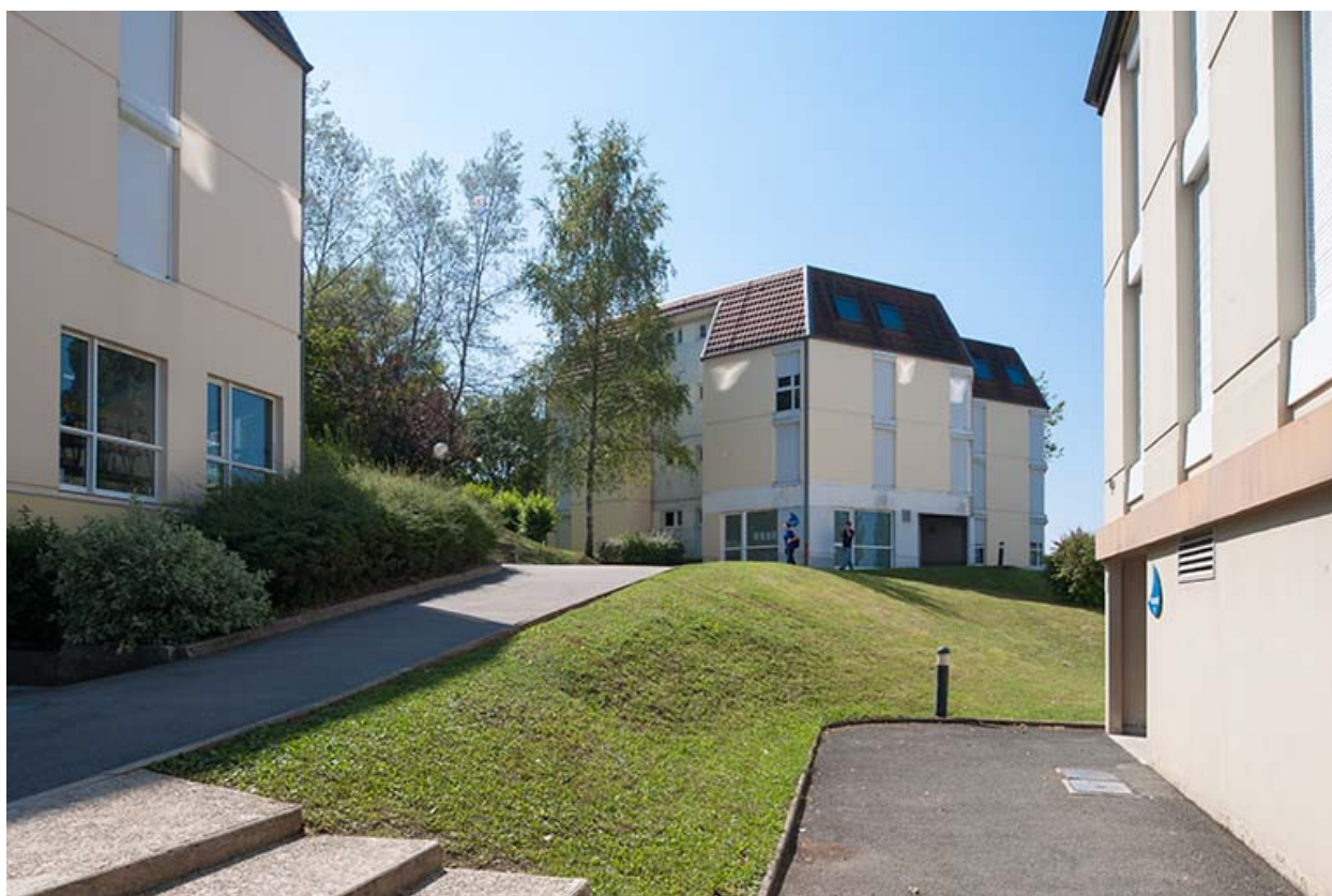
Les bâtiments d'hébergement.
