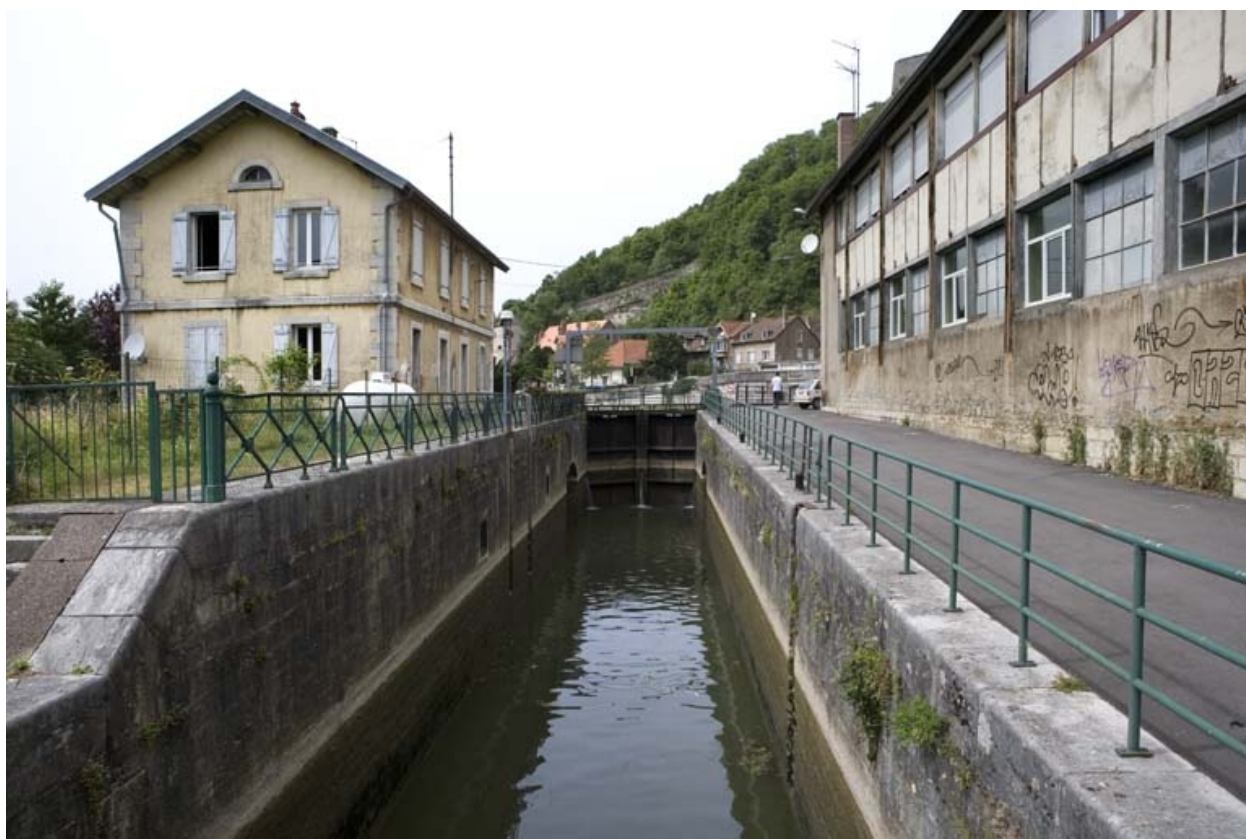
Intérieur du sas, depuis l'aval.
