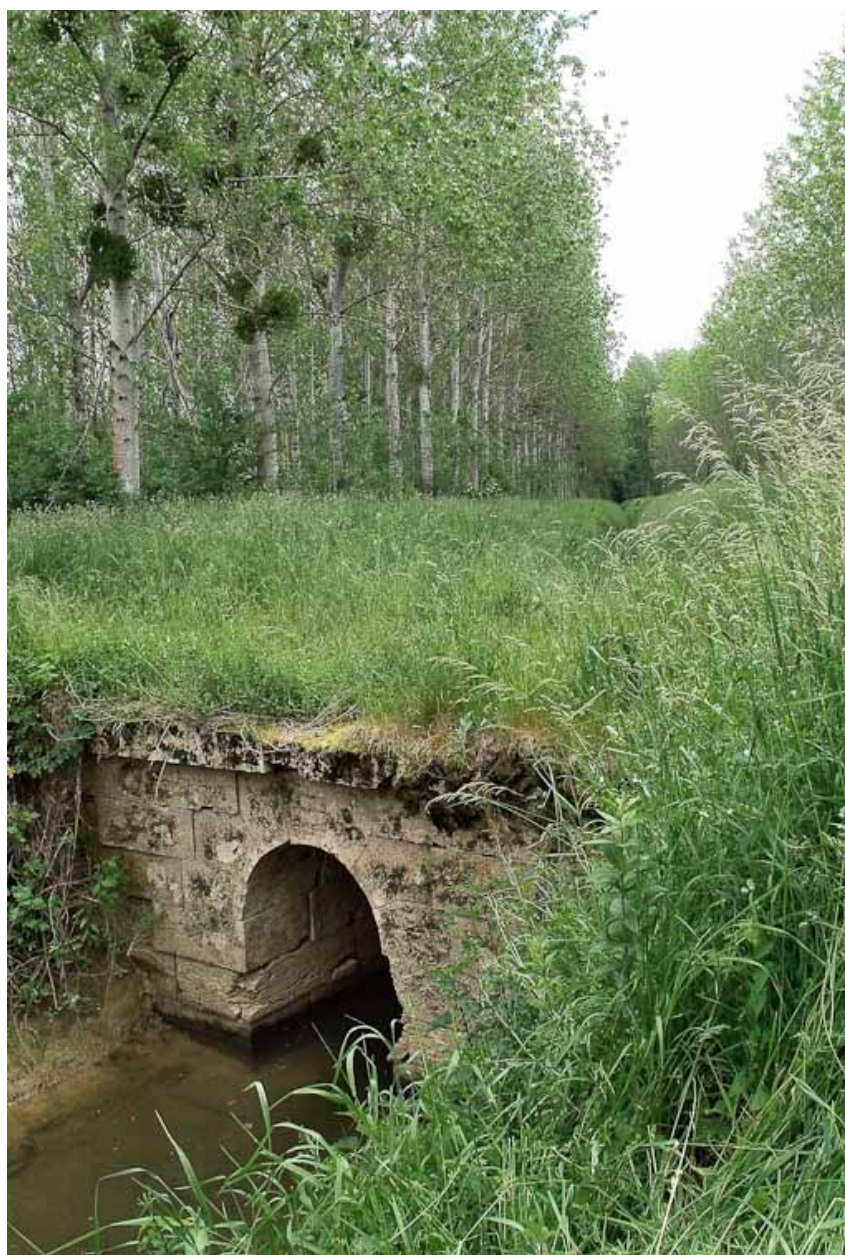
Ponceau, vue rapprochée.
