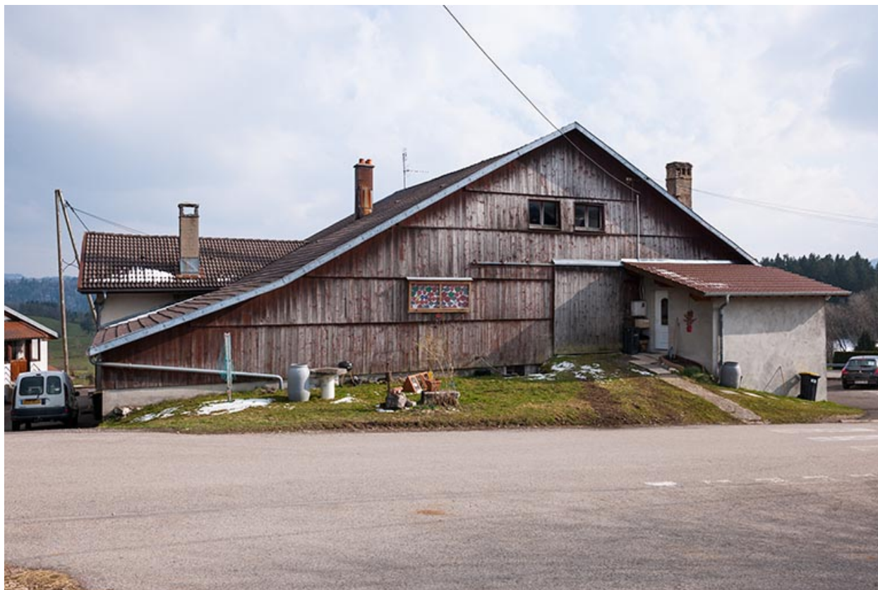
Ferme : façade postérieure.
