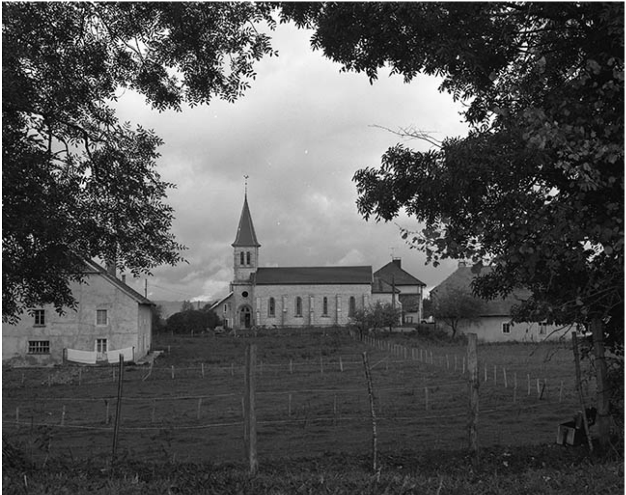
Façade latérale sud.
