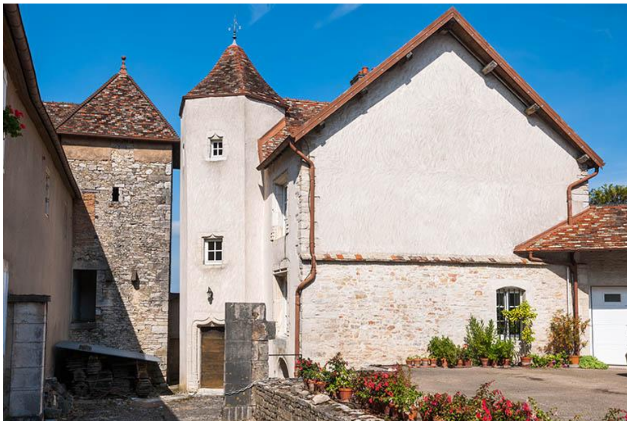
Ancienne maison située au nord-ouest
