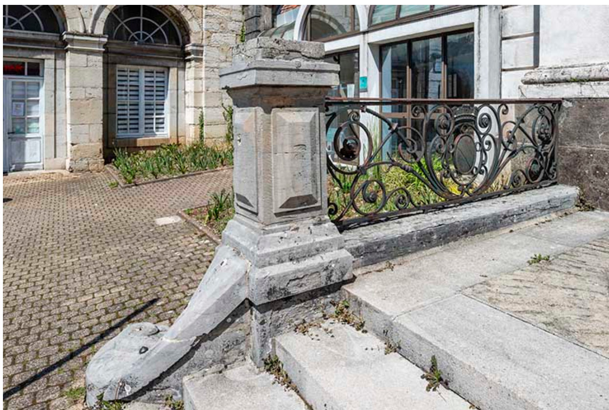
Garde-corps de la partie gauche.
