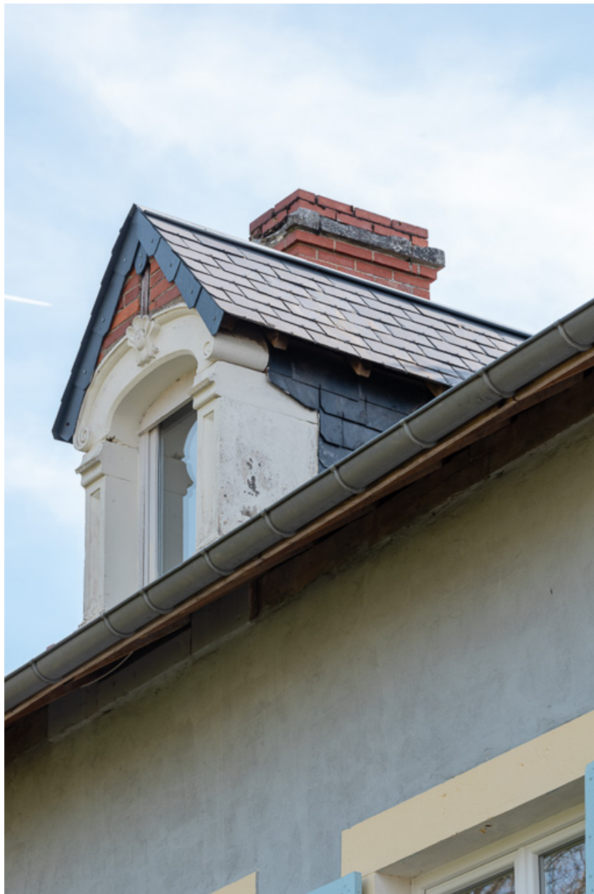
Lucarne de la façade nord-ouest.
