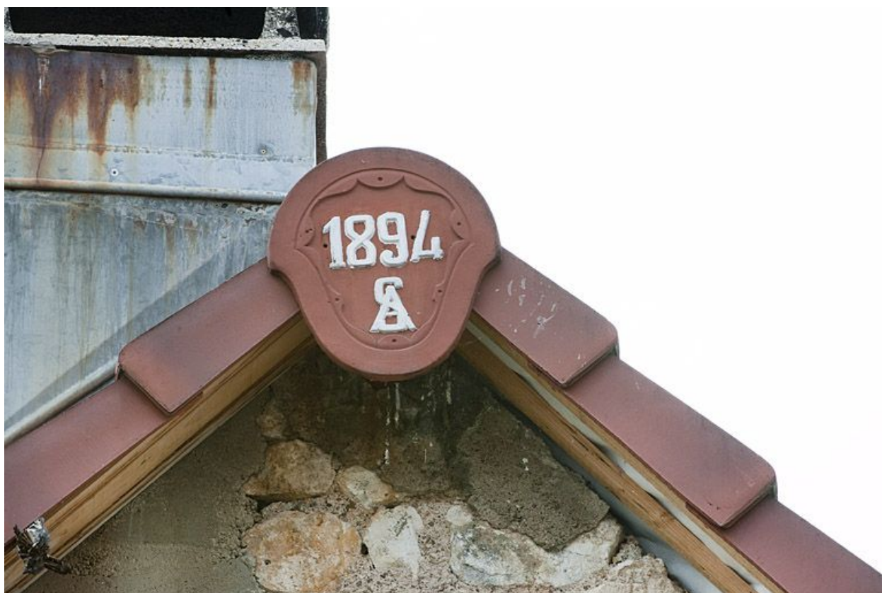
Antéfixe d'une maison (rue de la Gaieté).
