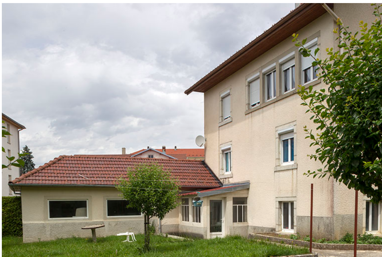
Façade postérieure et garage.
