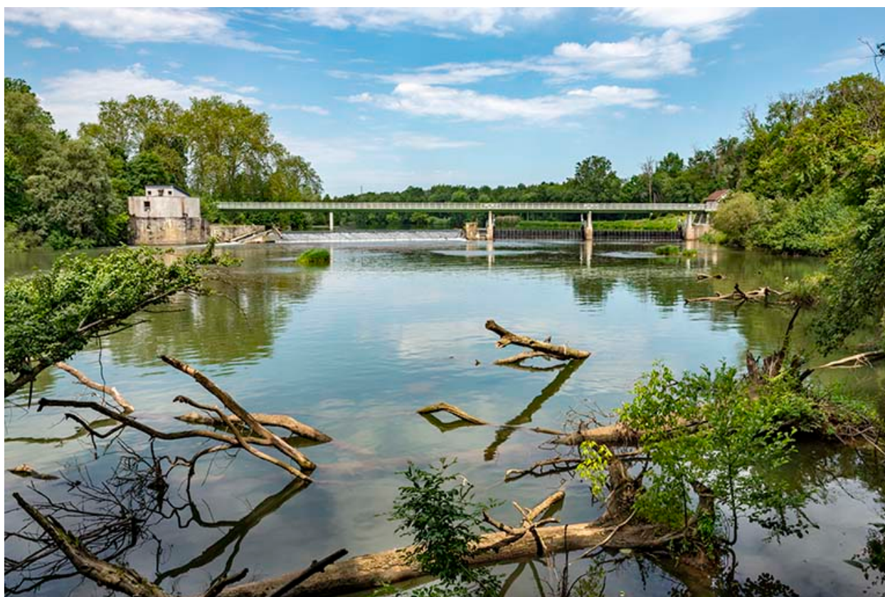
Vue générale depuis l'aval.
