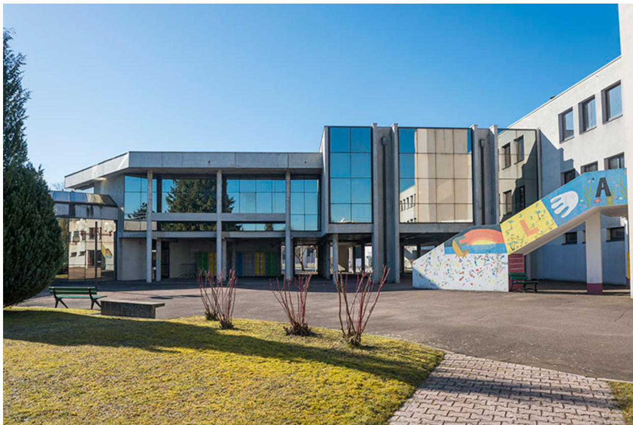
Façade nord du bâtiment d'accueil.
