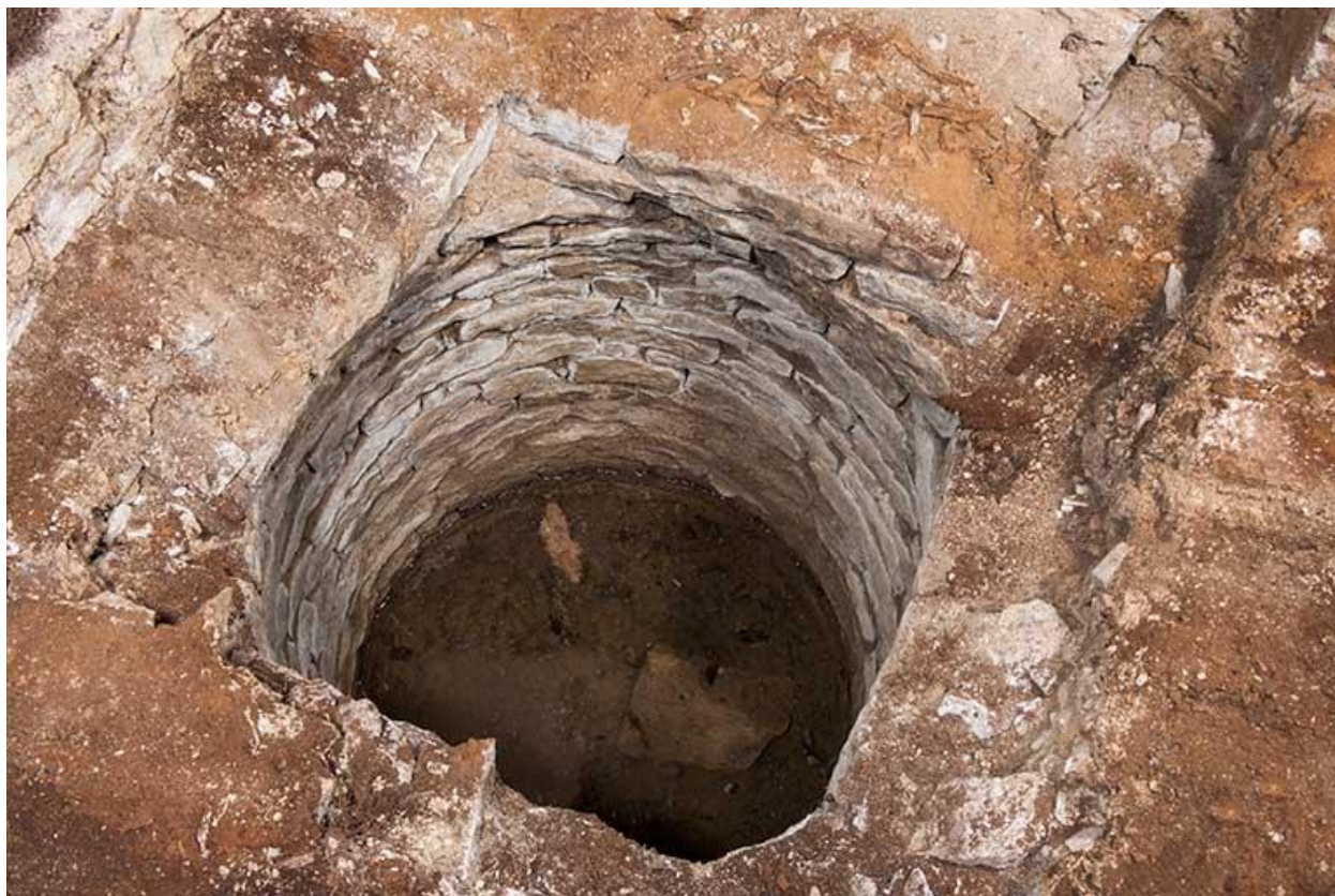
Le puits, situé dans la cave
