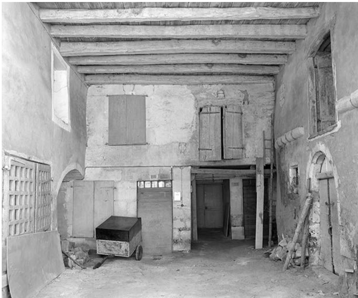
Façade antérieure : le passage plafonné.
