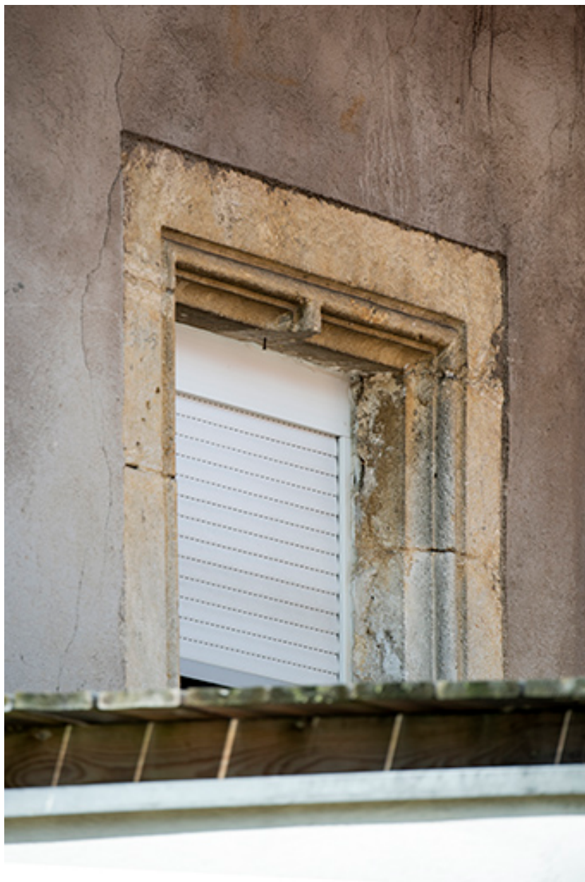
Ancienne maison : fenêtre à meneau (à l'étage).
