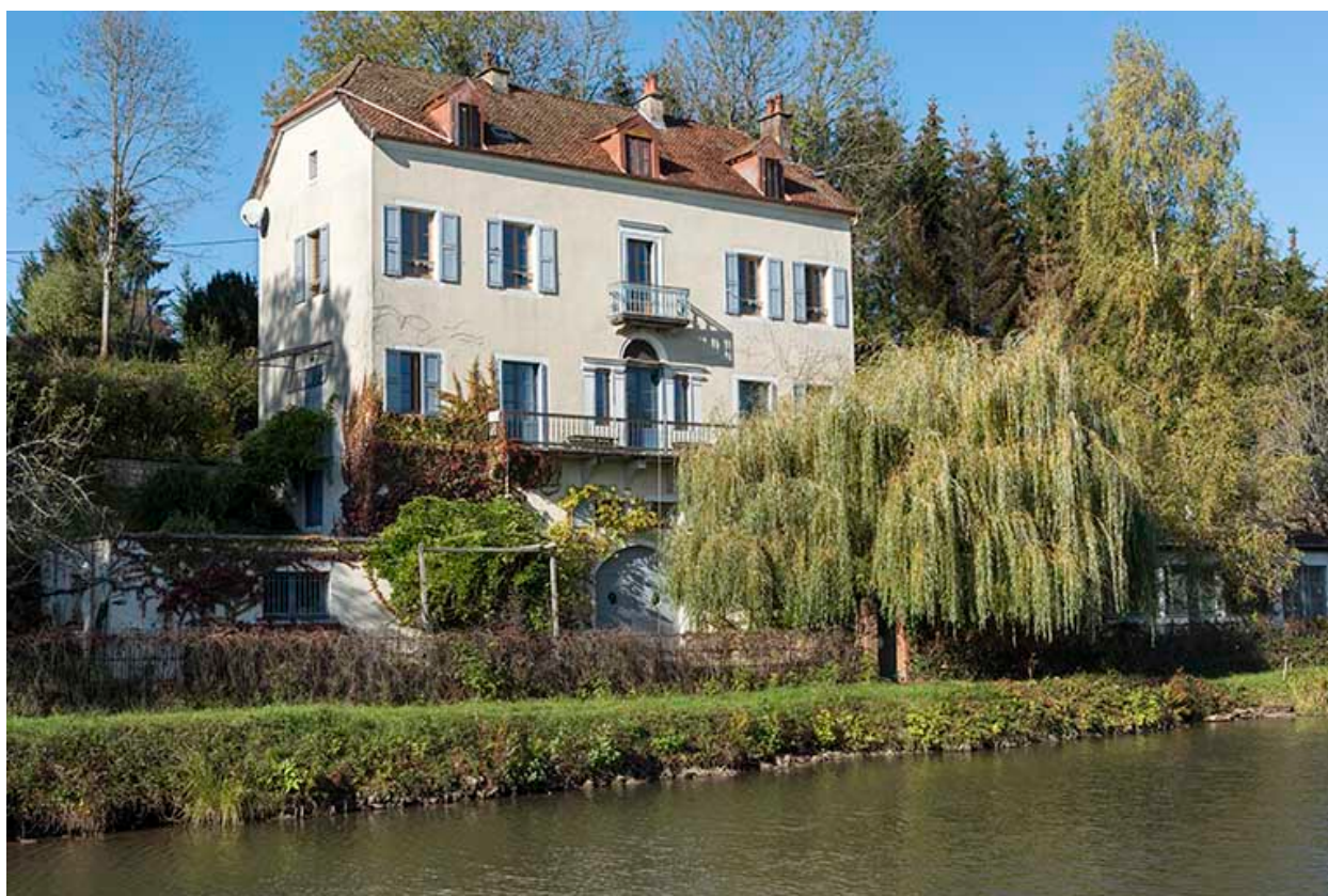
Maison en bordure du canal.
