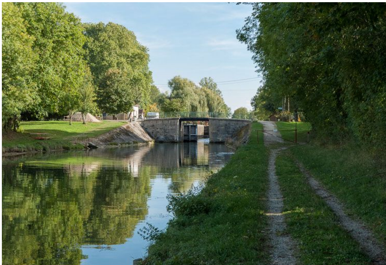
Le pont sur écluse vu d'aval.
