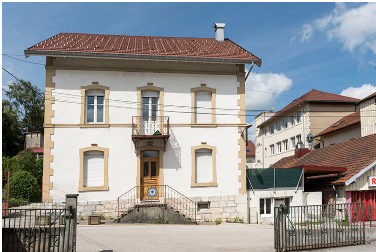
Maison chemin des Acacias : façade antérieure.
