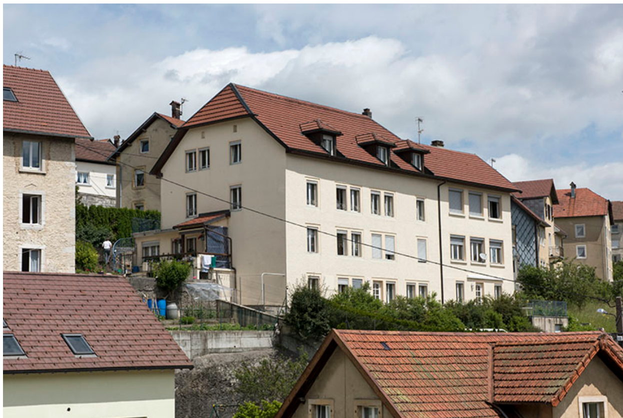
Façades postérieure et latérale gauche.
