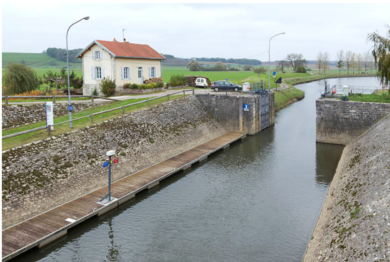
Les perrés inclinés de l'écluse de garde.
