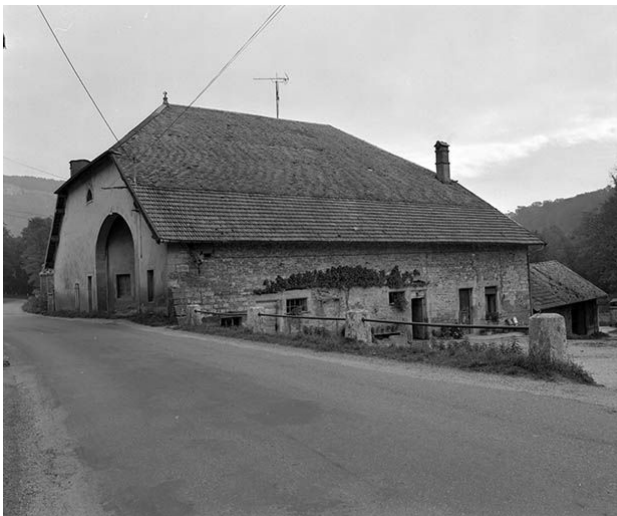
Elévation sur cour.
