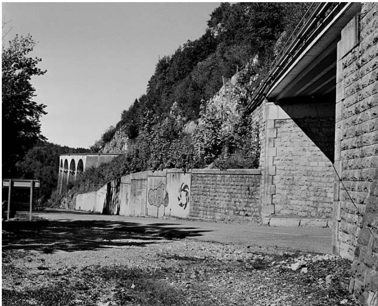
Elévation sud, de profil.
