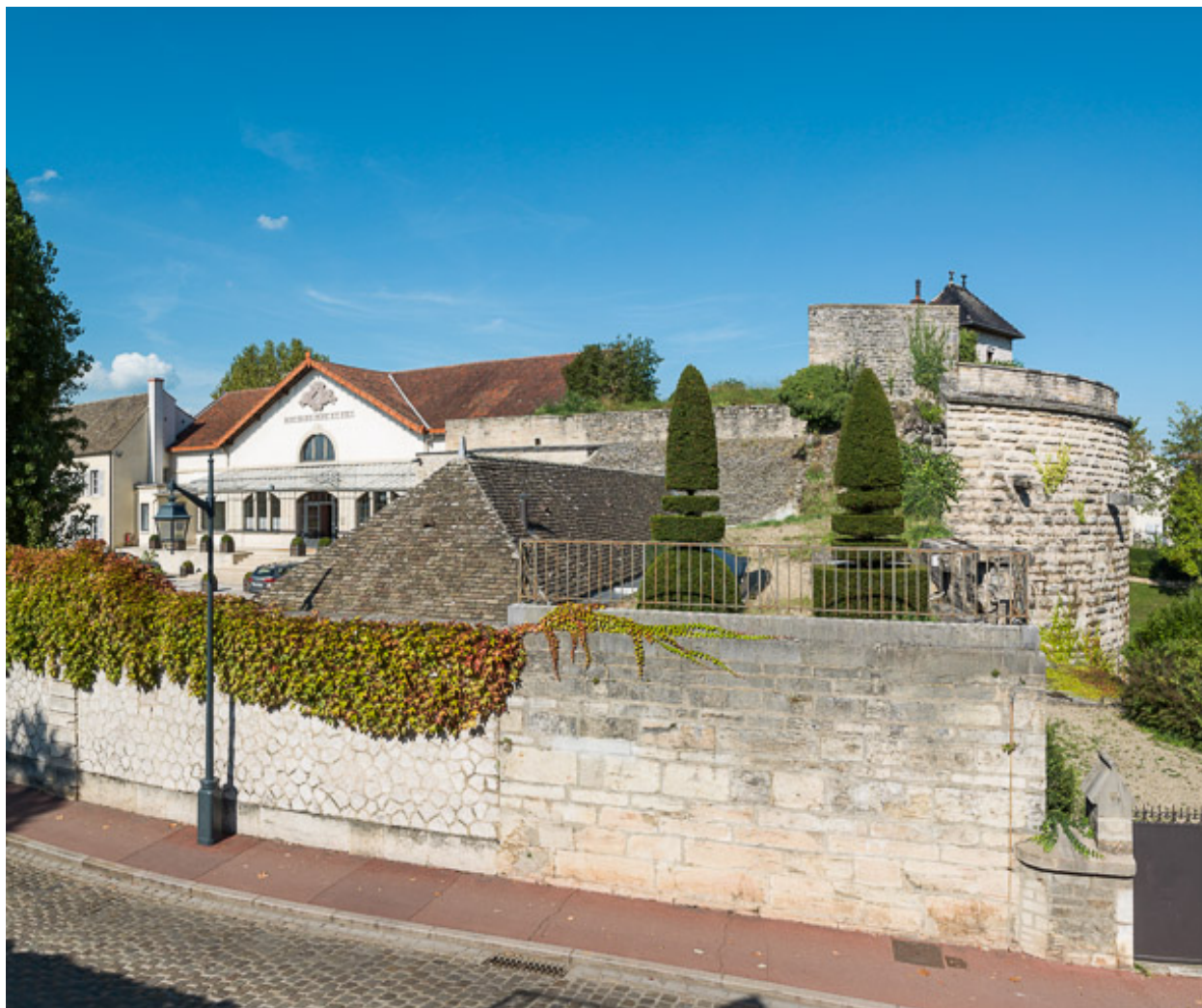
vestiges des remparts et rue du Château.
