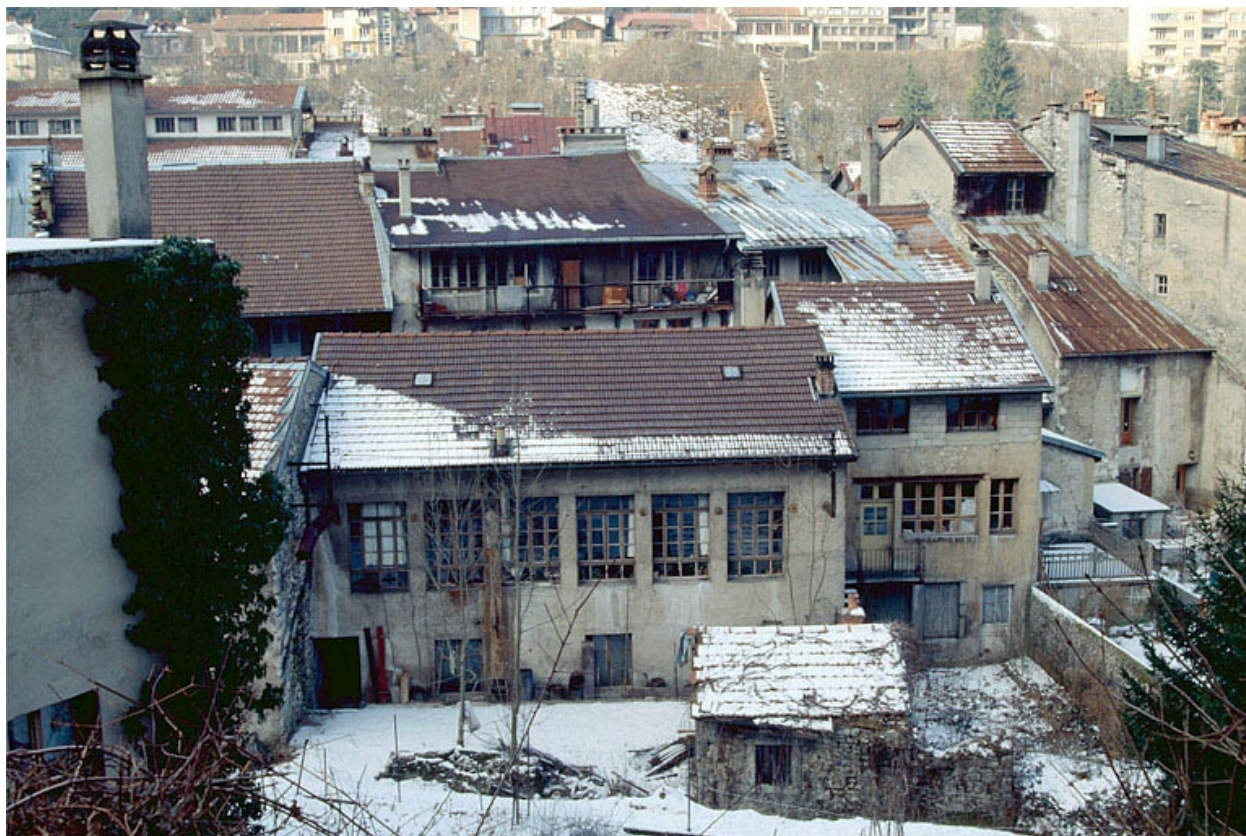
Façade postérieure des bâtiments sur cour.
