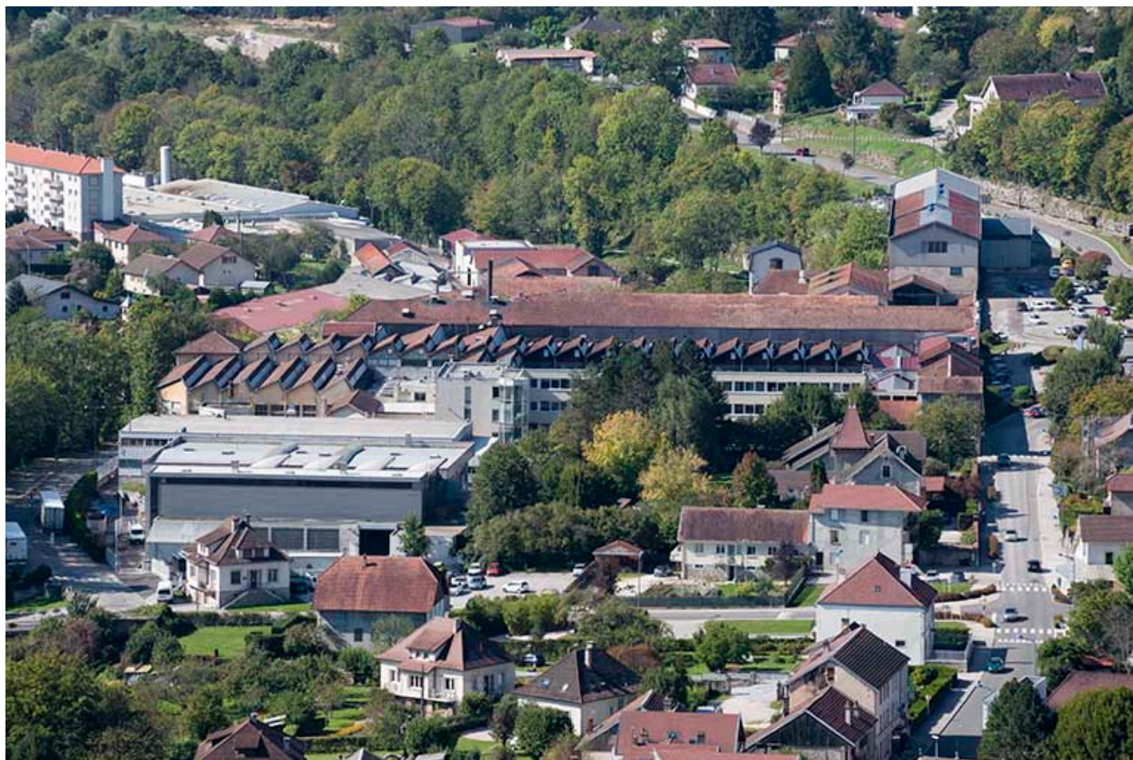
Vue d'ensemble plongeante depuis l'est.
