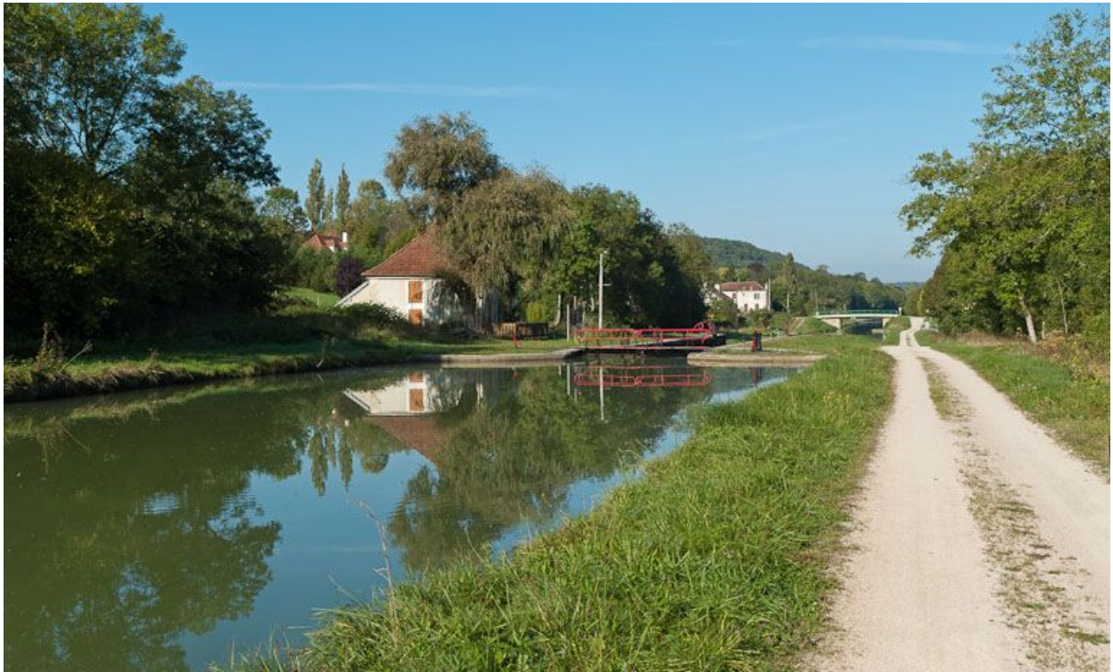
Vue du site d'écluse depuis l'amont.
