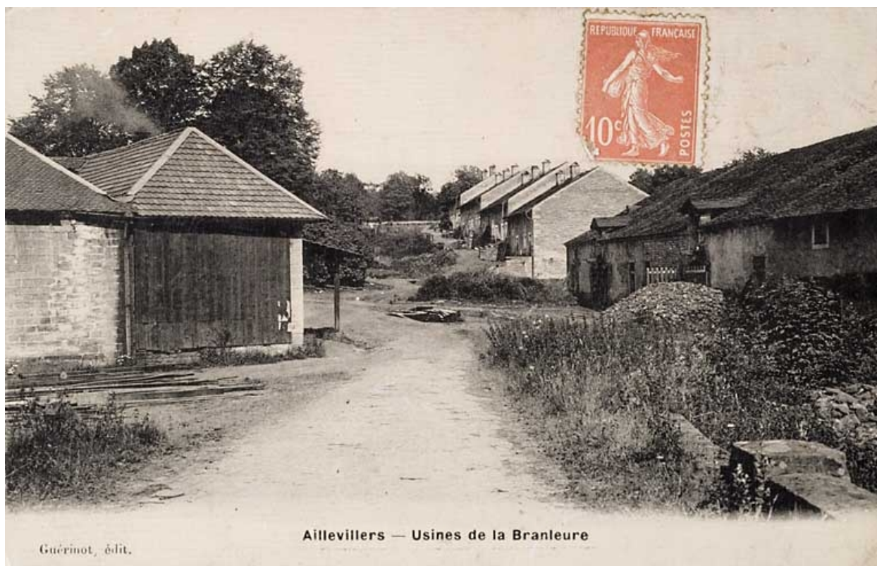
Ailevillers - Usines de la Branleure.
