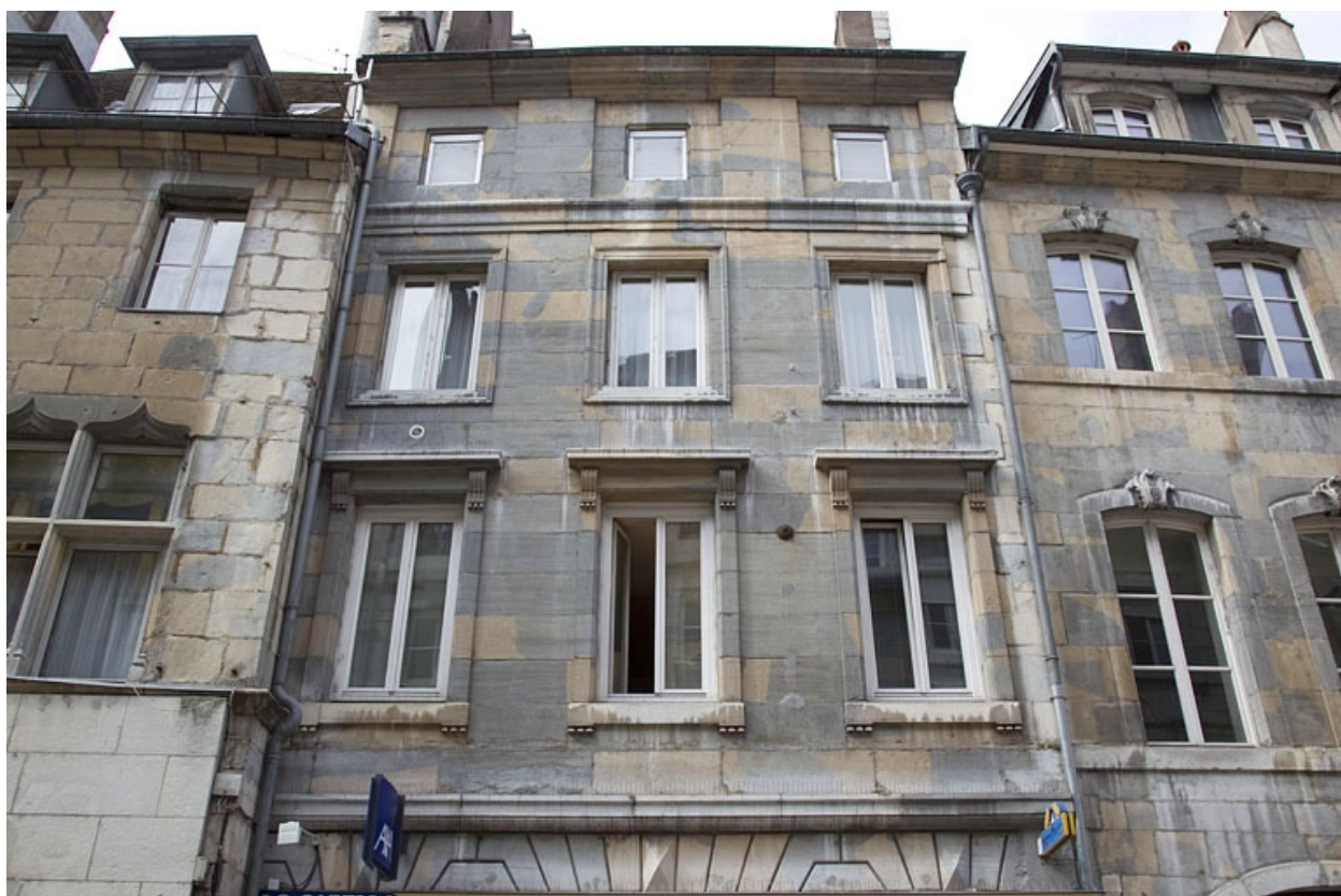
Façade antérieure : détail des étages, de face.
