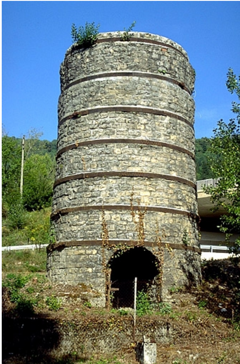
Usine de chaux et ciment Bouvet Ponsar et Cie, Champagnole : un ancien four à chaux.
