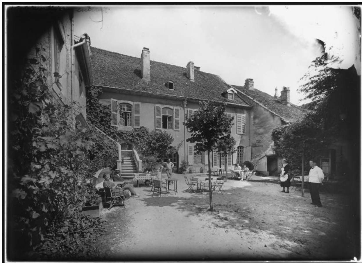
Cour intérieure [1re moitié 20e siècle].
